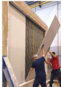
Fotos de montaje del trasdosado
