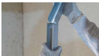
Insérer le clip'in dans le montant PSP
