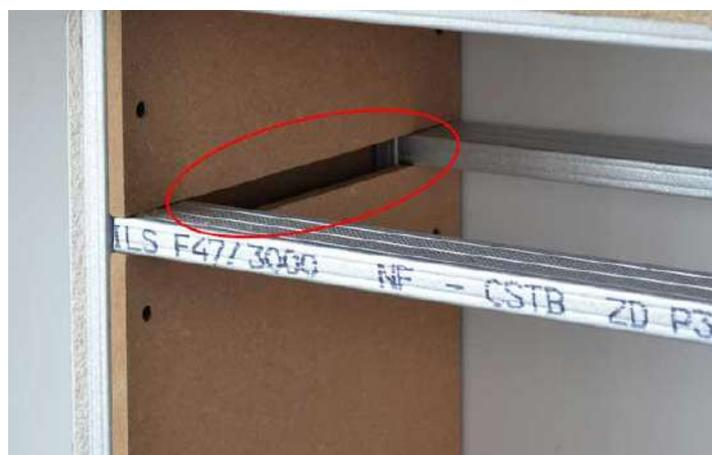
Lors du montage, ne soyez pas surpris par **le vide entre les profilés**. Inutile de créer des encoches dans les plaques verticales pour le combler.
