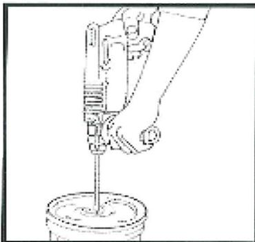
Employez un enduit standard, dans le compartiment du banjo. Mais soyez sûr de le mélanger uniformément, une texture assez lourde soit un peu plus légère que la texture de type enduit tout prêt en sceau, l'enduit doit être lisse et crémeux. Votre enduit doit sortir du banjo facilement. Si ce n'est pas le cas le malaxer avec plus d'eau.
